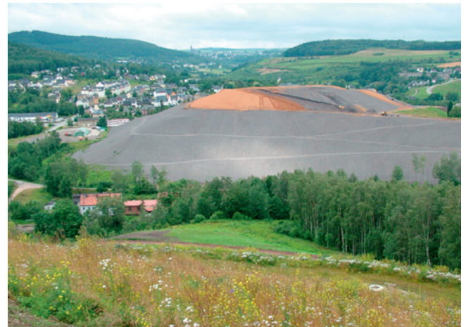
Profilierung und Abdeckung einer Halde des Uranerzbergbaus
