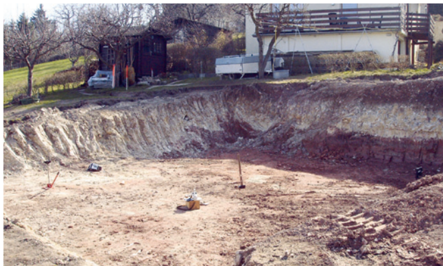
Bodenluft radonmessung in einer Baugrube
